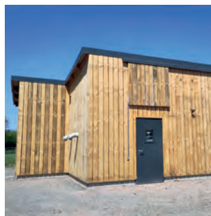
Chaufferie d'Echauffour (61) qui alimente dès mai 2026 1 EHPAD, 1 salle polyvalente et des logements communaux
